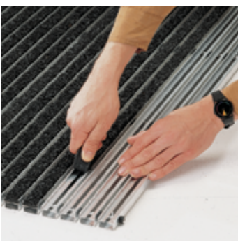
alte Rips entfernen
